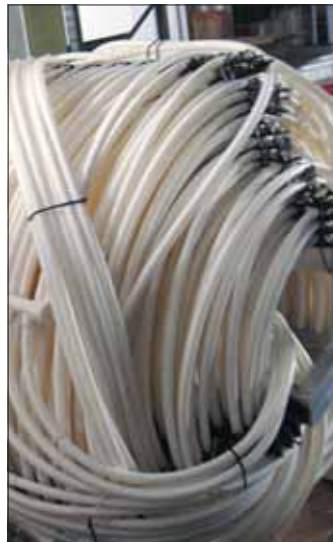
Wnętrze zbiornika akumulacyjnego wykonanego z rurek PE-RT
