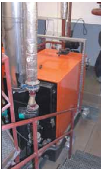
Nowa kotłownia przy dawnym zespole szkół
