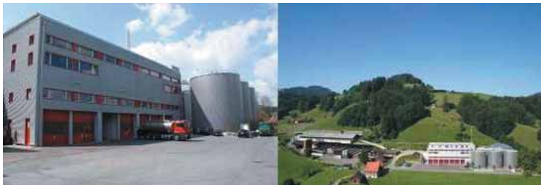
Zdjęcia 1, 2: Zakład utylizacji odpadów organicznych Jakob Bösch AG w Szwajcarii (www.boesch-entsorgung.ch)
