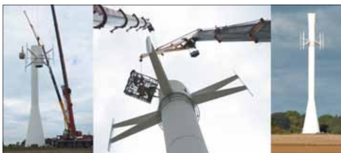
Rys. 4. Montaż turbiny wiatrowej na maszcie telefonii komórkowej firmy Ericsson [2]
