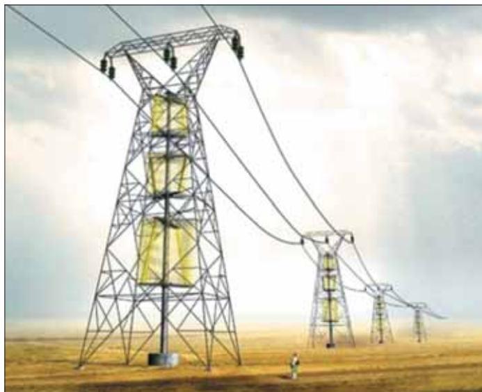
Rys. 1 Wizualizacja możliwości wykorzystania istniejących słupów linii napowietrznych wysokich napięć do zainstalowania turbin wiatrowych [1]
