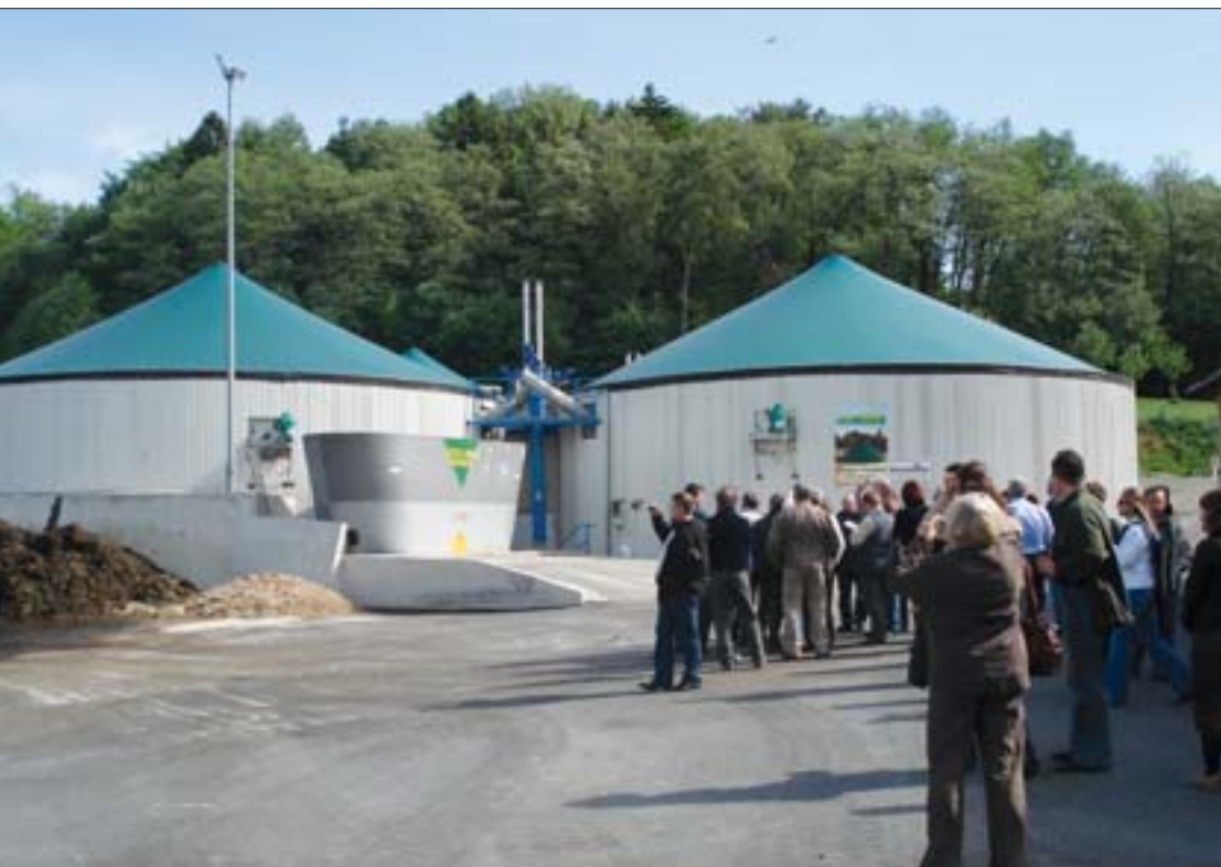
Biogazownia w Kirchheim
