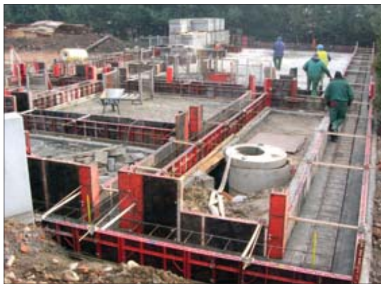
Fundamenty pod basen w Ośrodku Max
