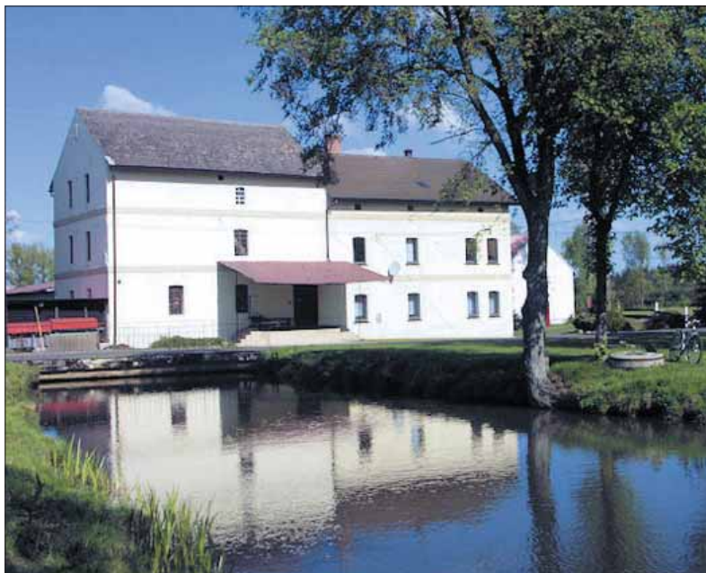
Elektrownia wodna w Żędowicach na Małej Panwi działa od 2000 r. Ma moc 50 kW.
