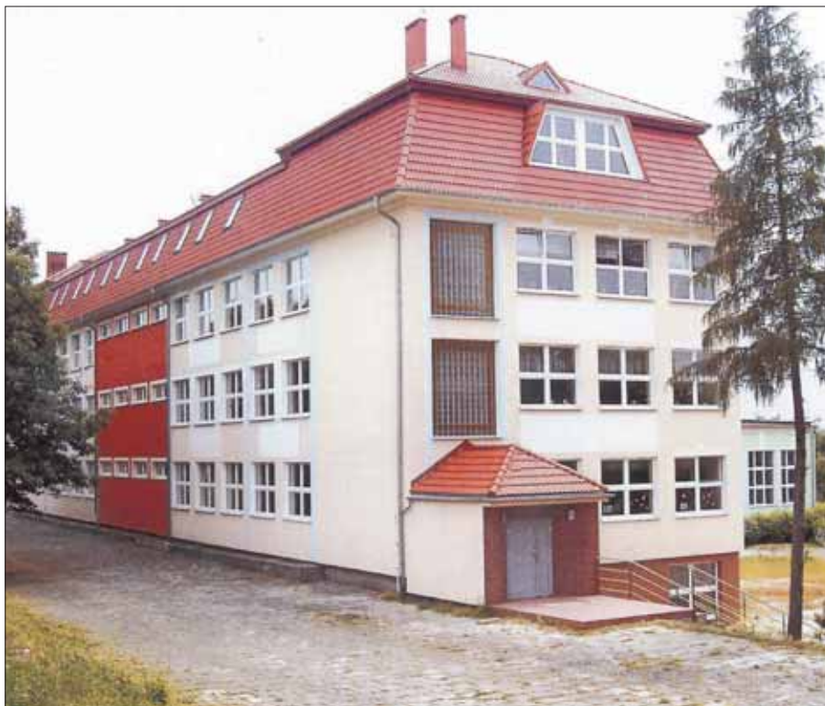
W szkole w Polskiej Cerekwi zainstalowano pompy ciepła i kolektory słoneczne.
