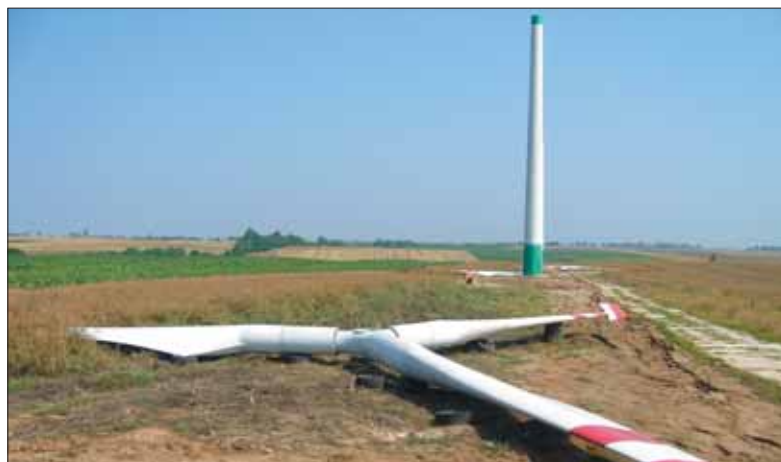
Elementy elektrowni czekają na końcowy montaż
