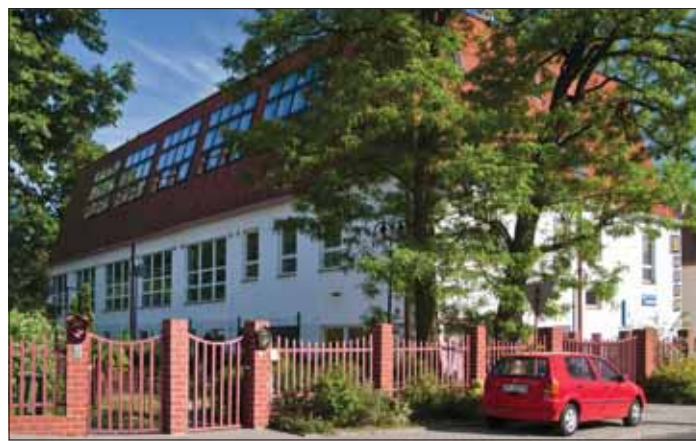
Kolektory słoneczne mają służyć m.in. do ogrzewania wody użytkowej na basenie w Tułowicach
