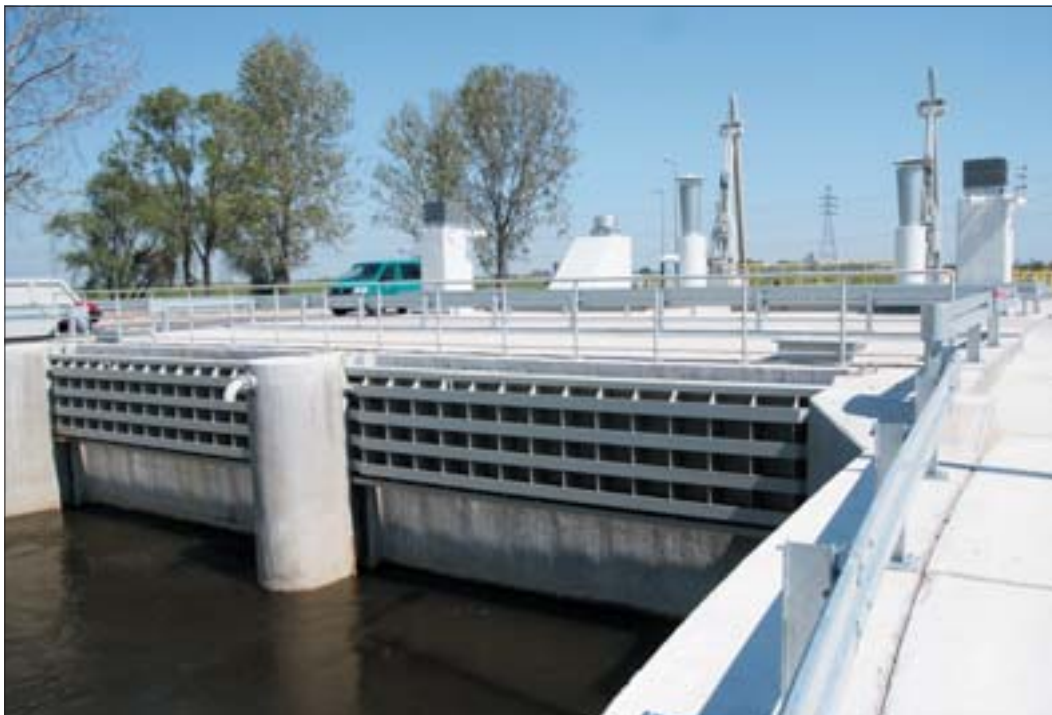
Elektrownia w Dobrzenu Wielkim ma moc około 1,6 MW. Oznacza, że jest w stanie dostarczyć prądu do około 15. tys. żarówek.
