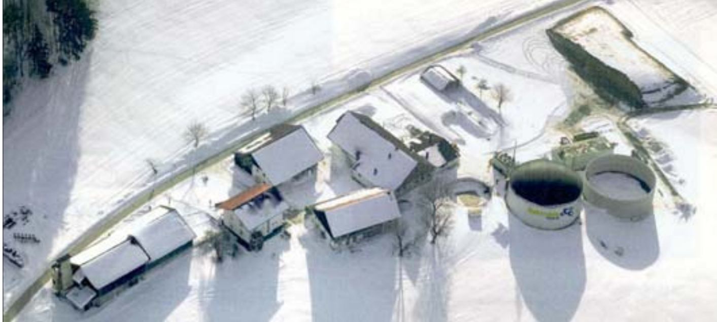
Rys. 3. Gminna biogazownia z elektrociepłownią (w budowie) o mocy 1 MWel z dwoma bioreaktorami.
