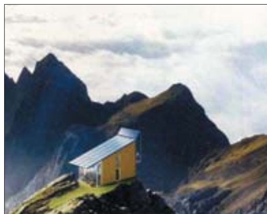
Rys. 4. Dom „ORLE GNIAZDO” z plusowym bilansem energetycznym, wybudowany przez architekta Disch z Freiburga, RFN
